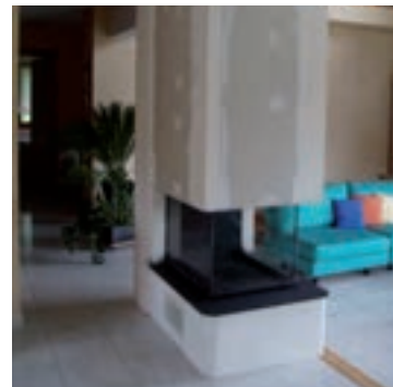
HABILLAGE PLACO DE LA HOTTE ET INSTALLATION DE GRILLES D'AÉRATION
